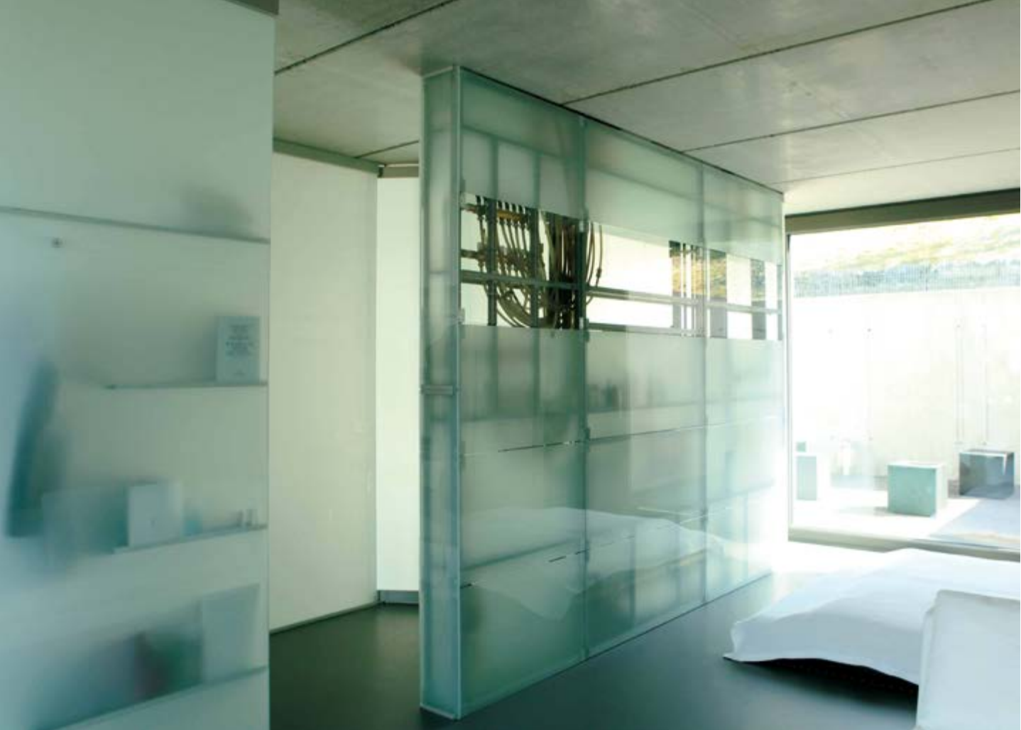
Ungewöhnliches Raumdesign – hier ist der Verteiler in die Innenarchitektur integriert
